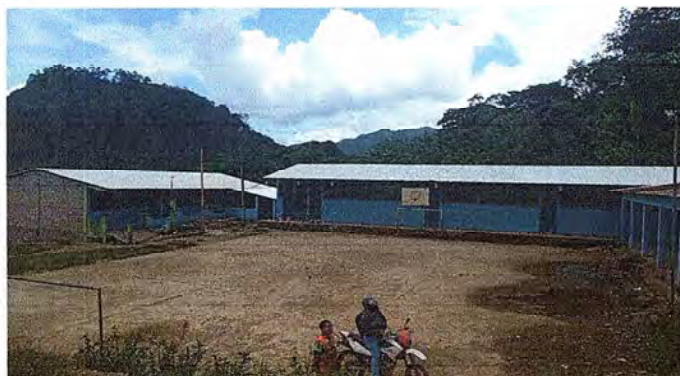
Foto 3: Mejoramiento de techo donde se observaba la acumulación de partículas inadecuadas que deterioran las laminas (modulos 2, 3 y 4).
