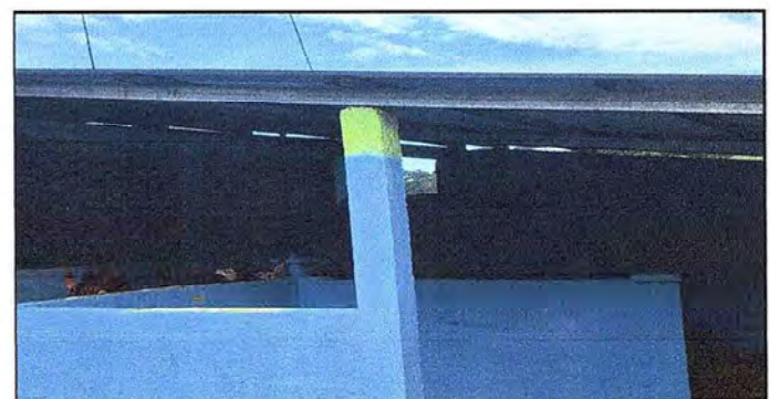
Foto 6: Sustitución de estructura de madera por metalica y cambio de laminas para evitar riesgos por deterioro.
