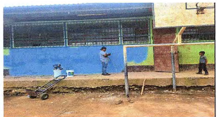
Foto 4: Mejoramiento de pintura exterior mas zocalo por deterioro de la misma (modulos 2, 3 y 4).
