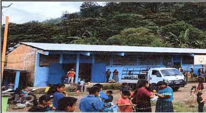
Foto 7: Mejoramiento de puertas y ventanas debido al deterioro de las mismas (módulo 3).
