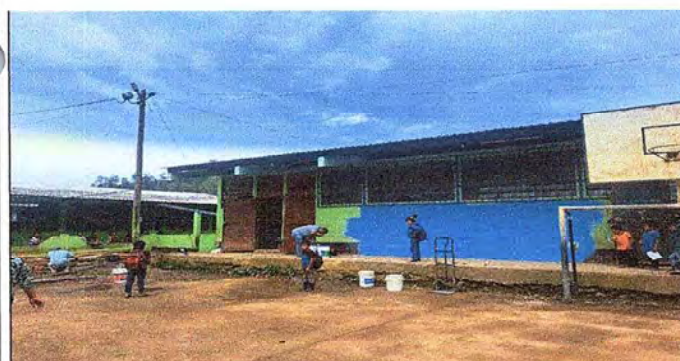
Foto 5: Mejoramiento de pintura exterior mas zocalo por deterioro de la misma (modulos 2, 3 y 4).
